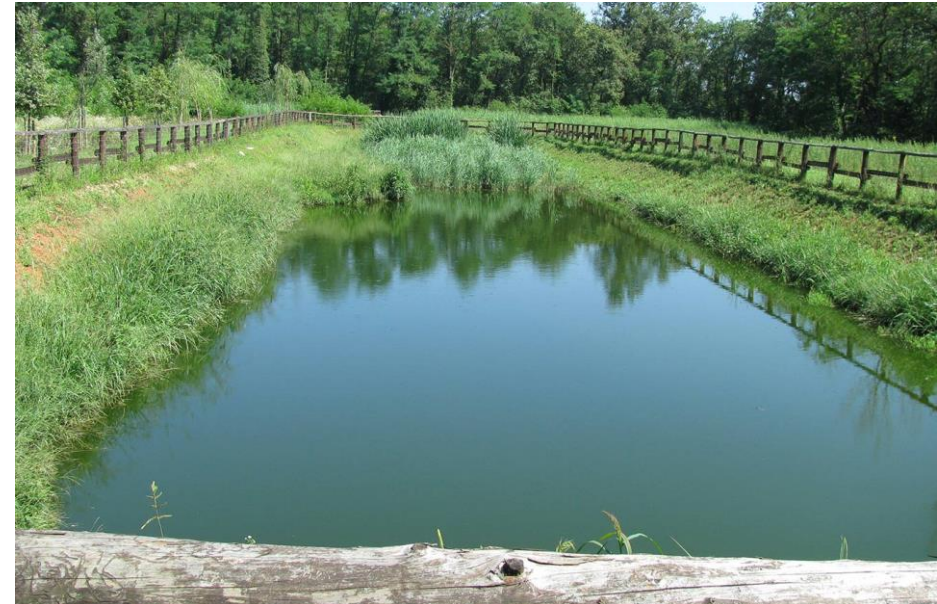
Impianto di lagunaggio
