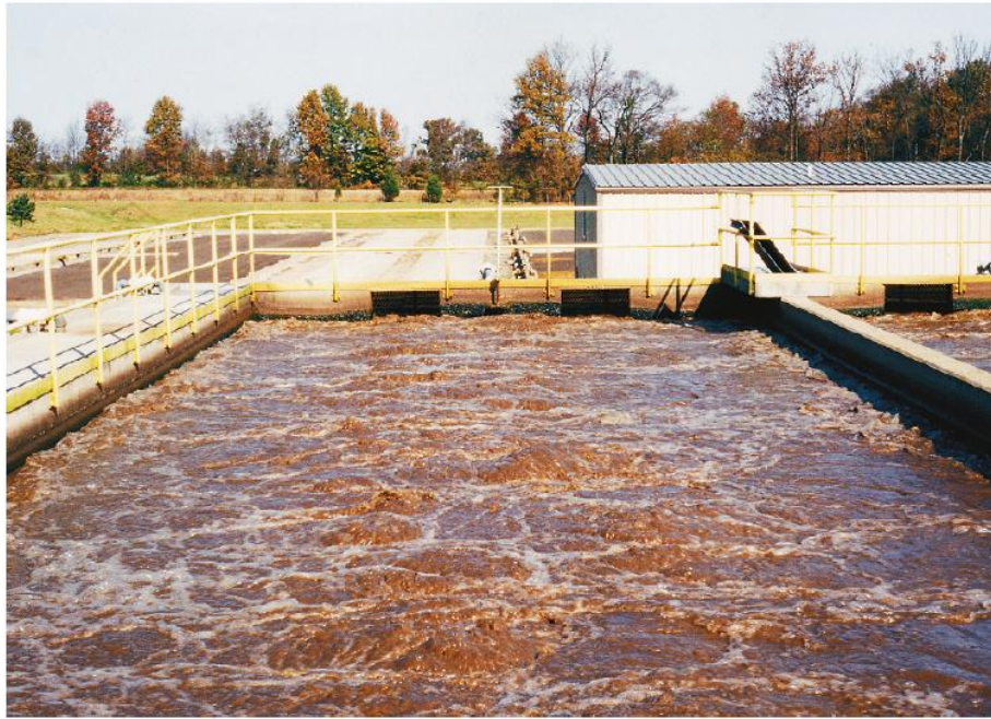
Figura 22.17 Processi di trattamento secondario aerobico delle acque reflue. I riquadri (a) e (b) si riferiscono al metodo di trattamento cosiddetto a fanghi attivi. (a) Vasca di aerazione di un sistema a fanghi attivi in un impianto metropolitano di trattamento delle acque reflue. La vasca è lunga 30 m, larga 10 m e profonda 5 m. (b) Schema di flusso delle acque reflue attraverso un impianto a fanghi attivi. Il ricircolo dei fanghi attivi in testa alla vasca di aerazione funziona da inoculo dei microrganismi responsabili della degradazione ossidativa dei composti organici presenti nelle acque reflue in entrata. (c) Metodo del filtro
