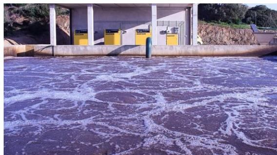
**Bulking viscoso o filamentoso:** elevata produzione di materiale extracellulare da parte dei batteri o predominanza di batteri filamentosi
