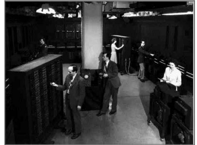
il termine Computer indicava le operatrici
